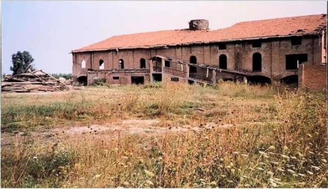
fig.20 - La fornace prima della demolizione
