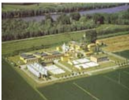
Il centro di depurazione delle acque proprietà di Acosea impianti
